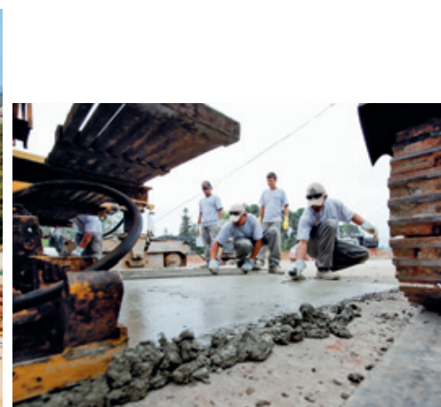
Pavimentação de estradas
