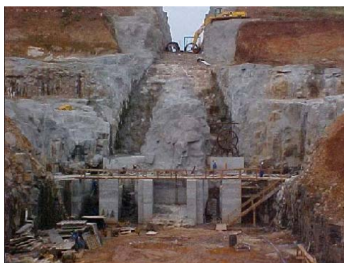
UHE São Bernardo - obra
