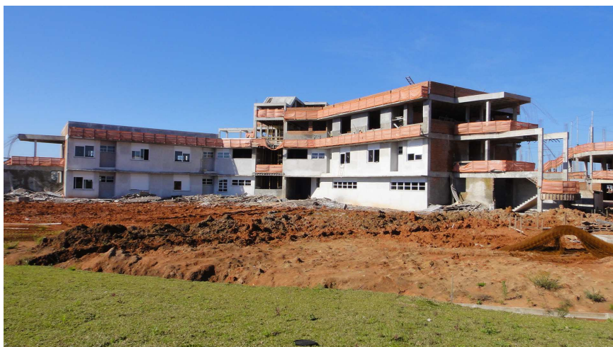
Foto da Obra em execução do Hospital Regional de Santa Maria. Fonte: SOP. 2011
