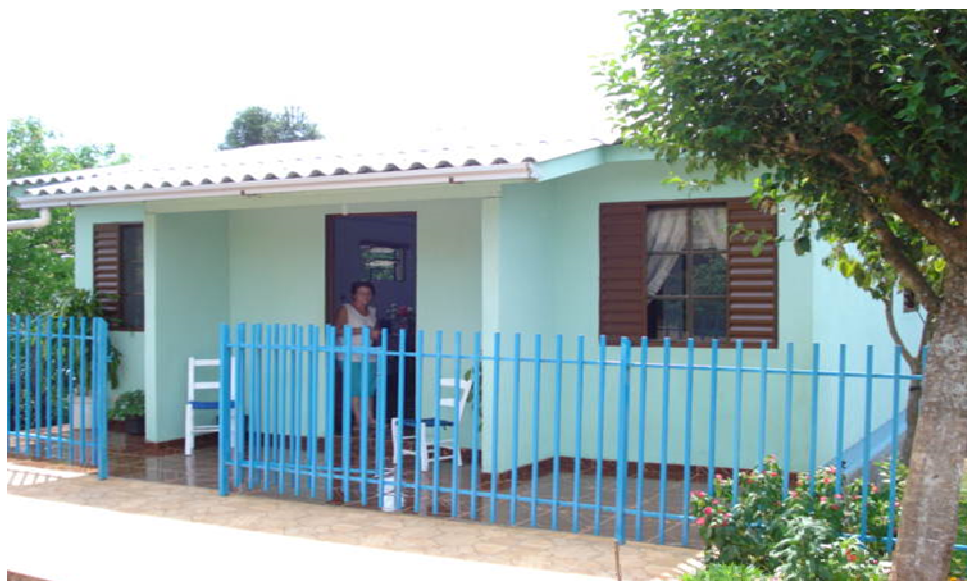
Casa construída em Cerro Grande - Programa Minha Casa Minha Vida com a complementação financeira de R$ 3 mil feita pelo Governo do Estado. Fonte: SEHABS.2011
